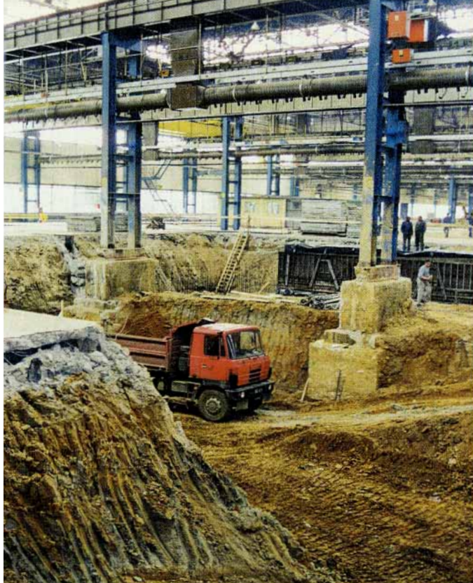
Hala nowego silnika jest obecnie gruntownie przebudowywana
